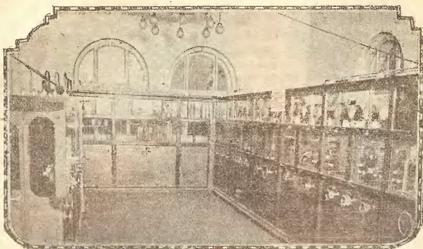
Общий вид передатчиков Треста заводов Слабого Тока. Справа мощный 20 киловаттный передатчик.
